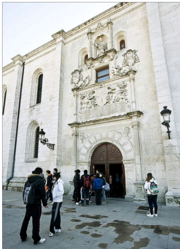
Se realizarán trabajos de conservación del claustro en el Mendoza. / ÁNGEL AYALA
